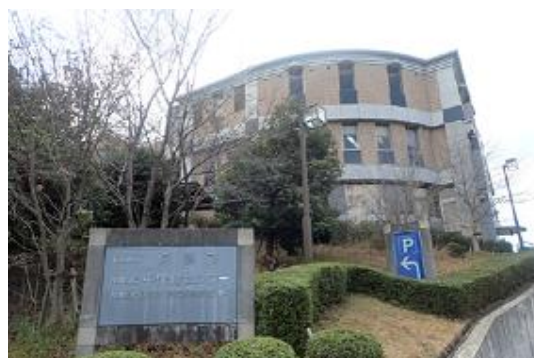
写真 1 和歌山市保健所
